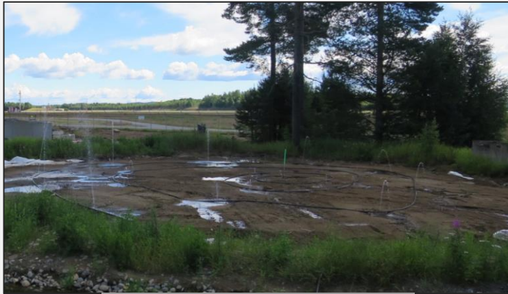
In situ utvasking over membransonen på P3
