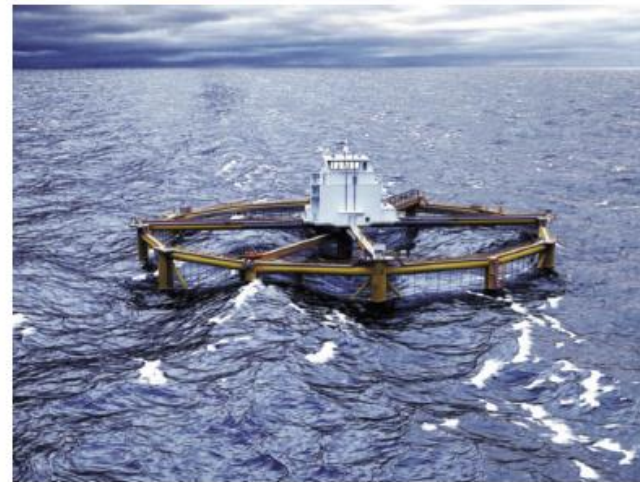
Opplegg Oppdrettsanlegg som Salmar ønsker å bygge har en diameter på 110 meter og en høyde på 67 meter. Foto: OCEAN FARMING / ILLUSTRASJON
