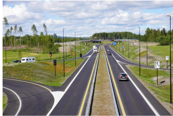
Rv. 3/25-Løten-Elverum – Byggherre Statens vegvesen CEEQUAL Excellent- Whole Team award
