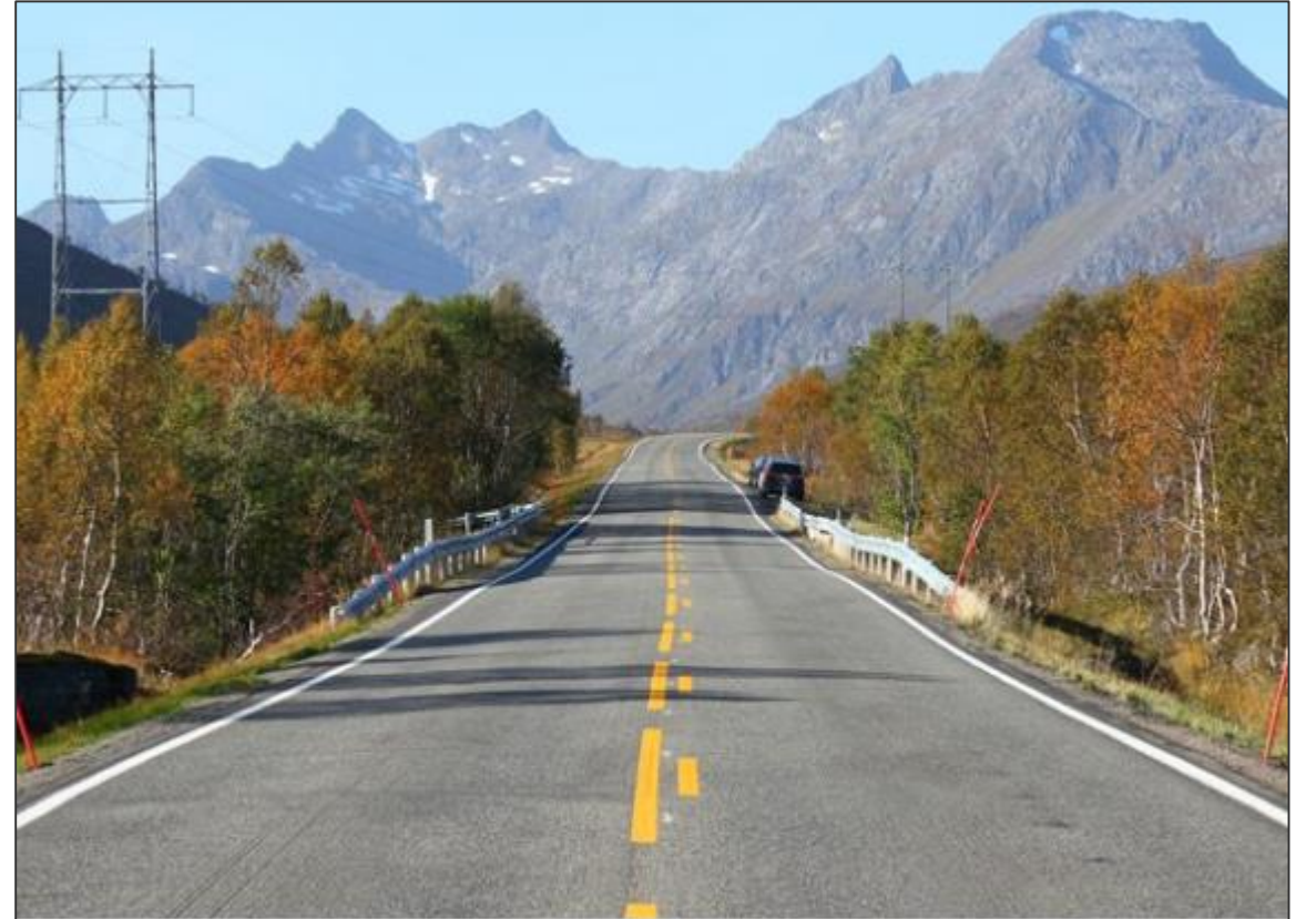
E10 - mot Lofast-krysset.
