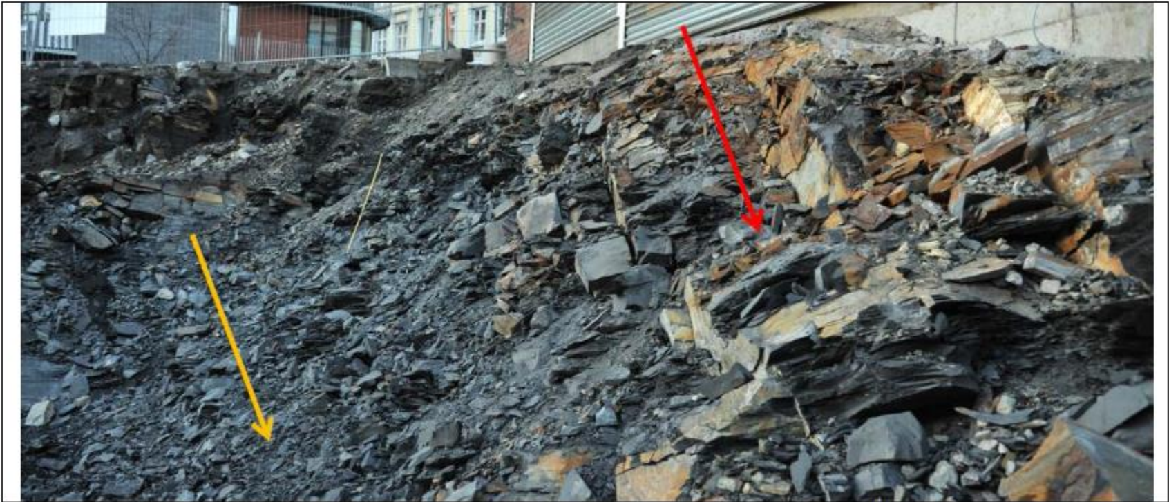
Figur 36: Galgebergledet ved Sofienberg i Oslo. Tilsynelatende grov oppsprekking (rød pil) , men her kom skiferen ut nesten av seg selv og kunne krafses med skuffe på gravemaskin (gul pil) .
