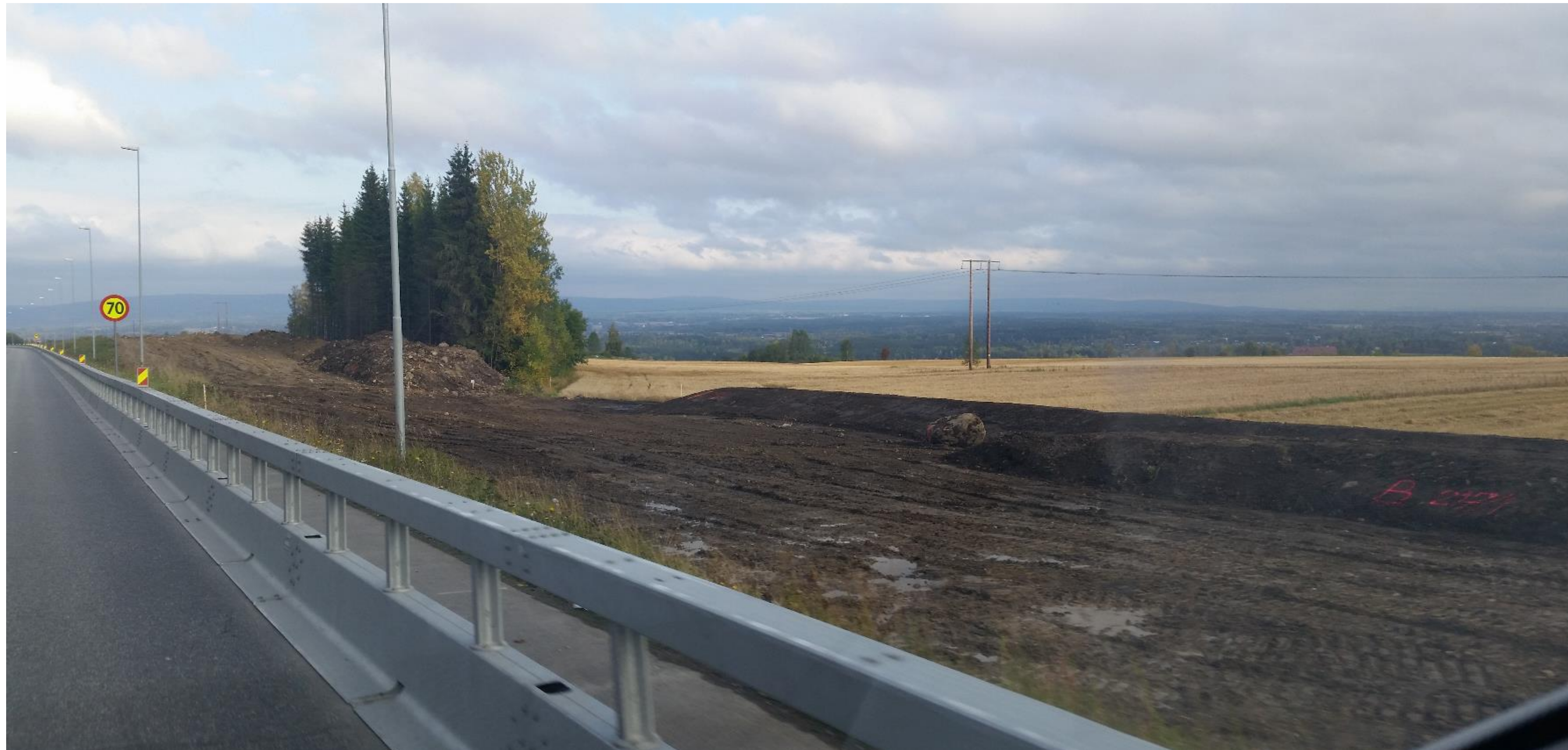
Matjord i ranker, fordelt A, B og eventuelt C sjikt. Toppmasser med svartlistearter. XRF
