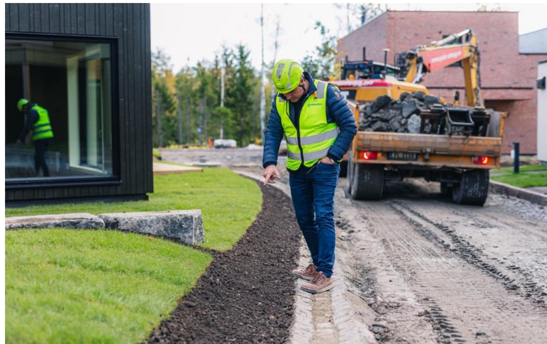
Sirkulær jordblanding lagt ut på grøntarealene på Dyst av prosesserte jord- og steinmasser fra byggetomta
