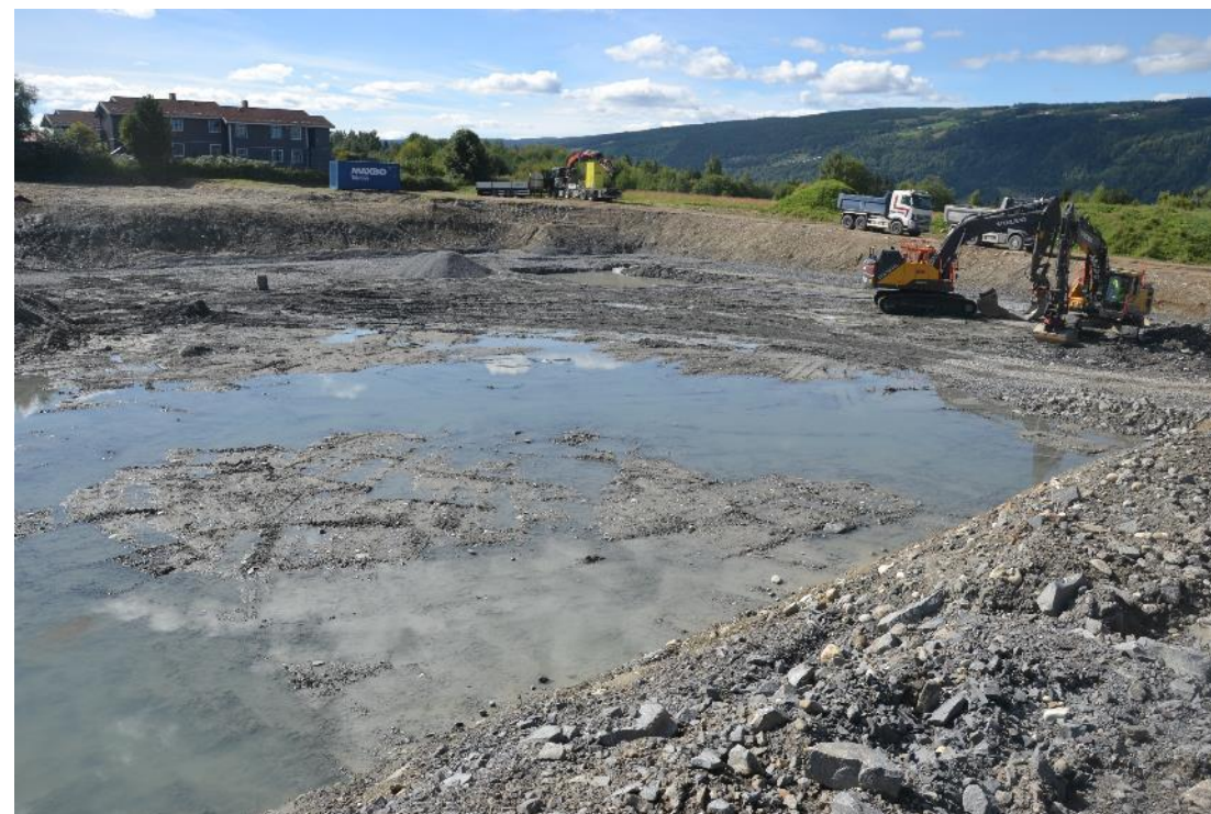
Byggegrova for første byggetrinn etter graving av parkeringskjeller
