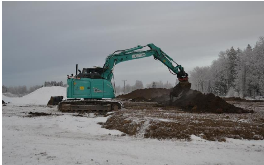
Utjevning av matjordlag (A-sjikt) på B-sjiktflate på telet jord
