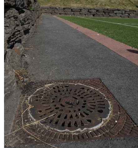
Fiberduk i alle avløpskummer på Føykabanen
