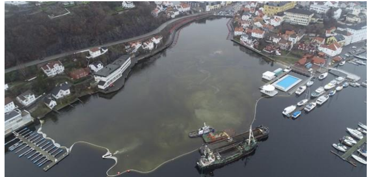
Tildekking av forurensete sedimenter i Arendal havn pågikk fra november 2018 til april 2019. Her er tiltaksgjennomføring i Kittelsbukt vist. Foto: Arendal kommune
