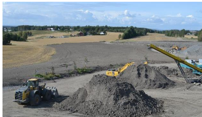
Topplag av produsert moldholdig anleggsjord utlagt sommer 2021
