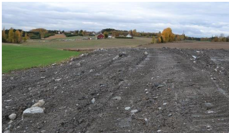
Masselagringsområde planert med bulldoser
