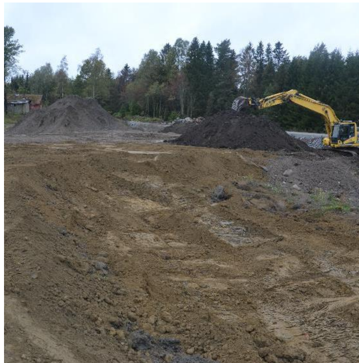
Utlegging av alle jordlag foregår med gravemaskin uten komprimering
