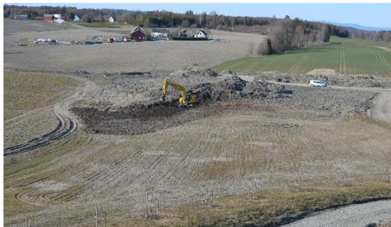
Mer jordløsning og utsortering av stein og blokk med gravemaskin
