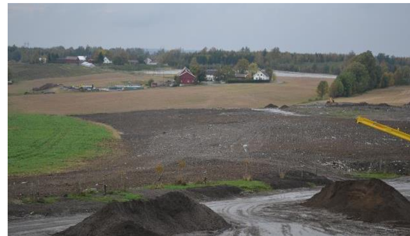
Utlagt grusholdig, steinholdig og moldholdig jordlag høst 2020
