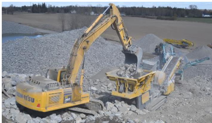
Knusing og sortering av utsortert stein og blokk og sprengstein
