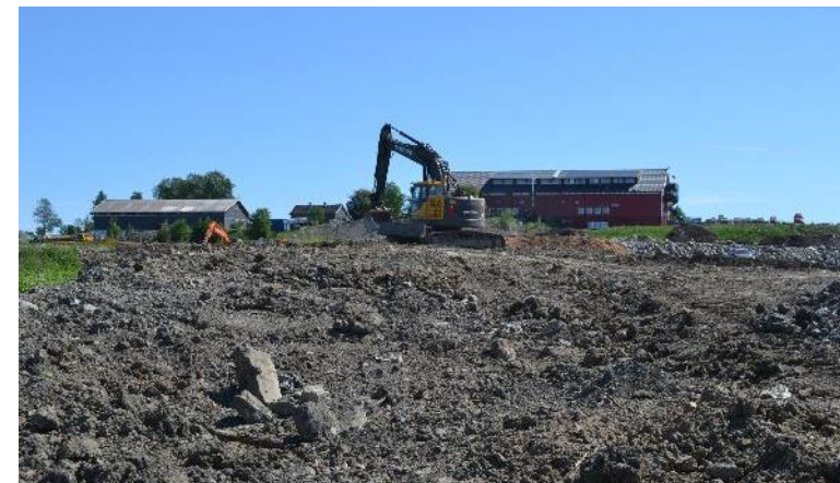
Jordløsning med gravemaskin
