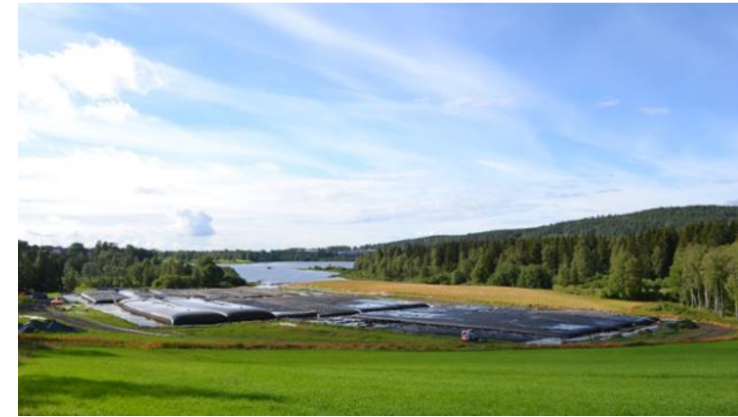
Avvanning av mudringsmasser i geotuber 2017
