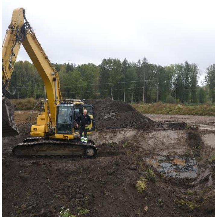
Oppbygging av jordsmonn med C-sjikt, B-sjikt og A-sjikt med tilkjørte masser
