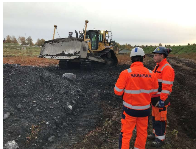
Moreneutlegging - komprimeringstest med bulldoser
