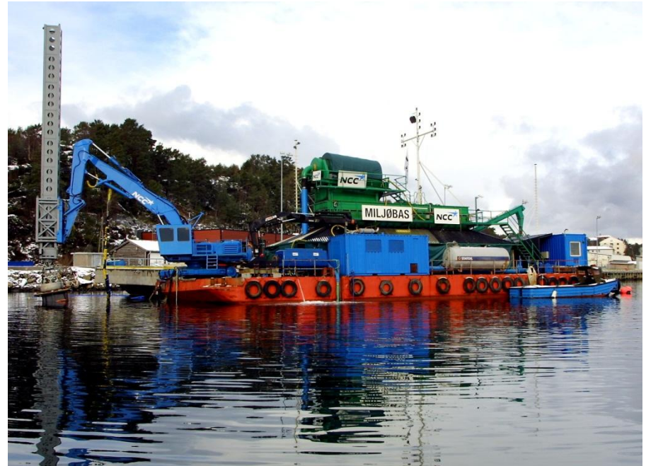
Sugemudringsutstyr montert på en gravemaskin på lekter (Haakonsvern, Bergen)
