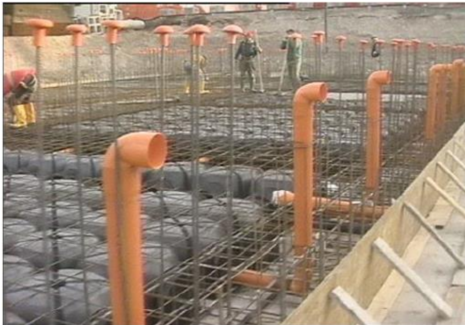
Gasstiltak under bygging. Kilde: Region Hovedstaden, 2021, Indeluftsikring i nybyggeri. version 2.3
