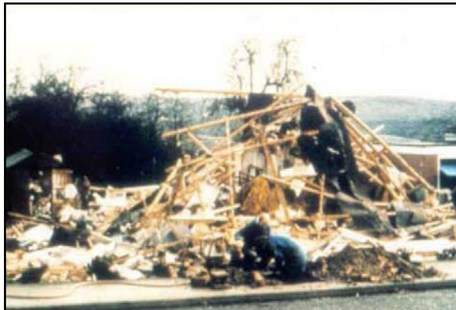
51 Clarke Avenue, Loscoe, Derbyshire, England etter metaneksplosjon kl. 6:30, den 24, mars 1986. Tre personer ble alvorlig skadd.
